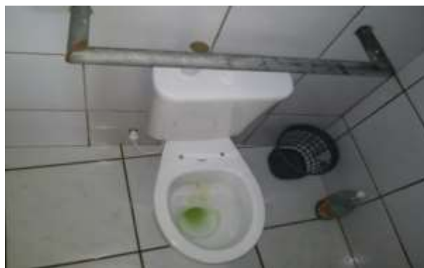
Figura 10 Barra de apoio corroído pela ferrugem da E.M.E.F. Estevão José Carneiro da Cunha Fonte: As autoras, 2015
